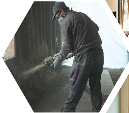
La totalidad de las paredes, con estructura de madera, se rellenan con 24 cm de cemento de cáñamo y se recubren por su cara exterior con fibra de madera de 8cm.
