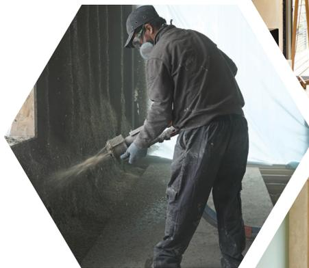
L'ensemble des murs à ossature bois de la maison ont été remplis avec 24 cm de béton de chanvre et doublés par l'extérieur d'une fibre de bois de 8cm
