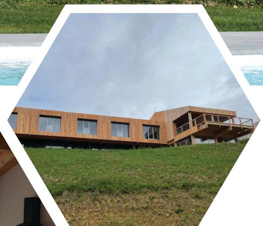
Construido en timber frame y madera laminada de abeto de procedencia sostenible centroeuropea y madera carbonizada de la zona para aportar durabilidad y estética.
