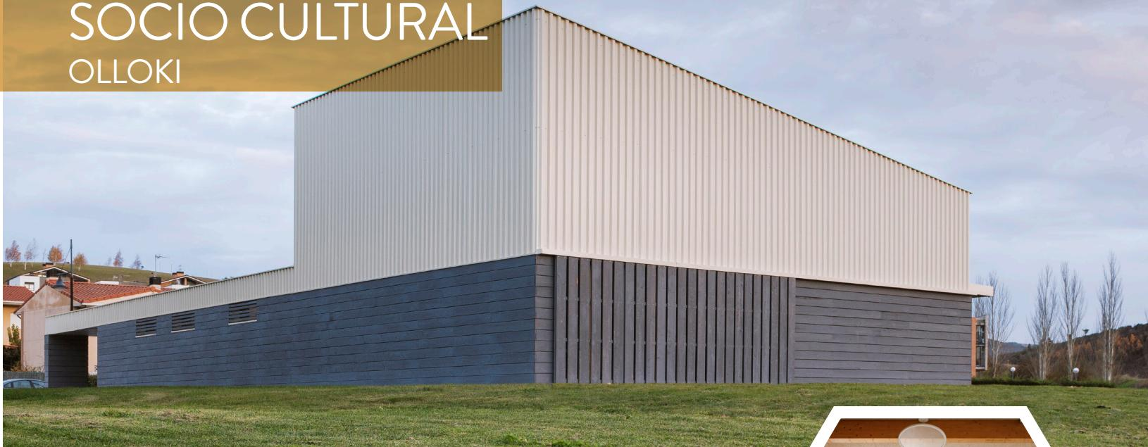
Equipamiento terciario cultural multiusos certificado Passivhaus Classic. Emplea masivamente la madera, tanto como sistema estructural, con CLT de pino, como para el aislamiento, subestructuras y acabados.
