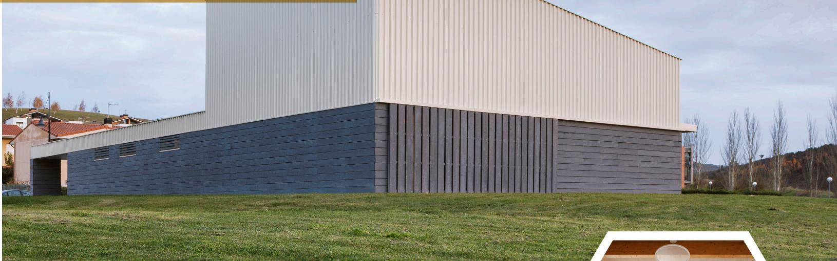
Installation tertiaire culturelle polyvalente certifiée Passivhaus Classic. Elle fait un usage massif du bois, tant comme système structurel, avec le CLT en pin, que pour l'isolation, les sous-structures et les finitions.
